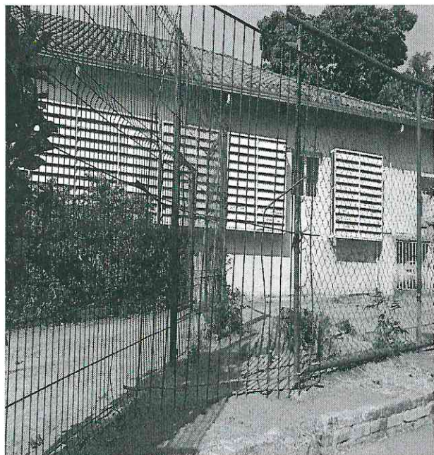
9. Entrada - substituição dos alambrados.
