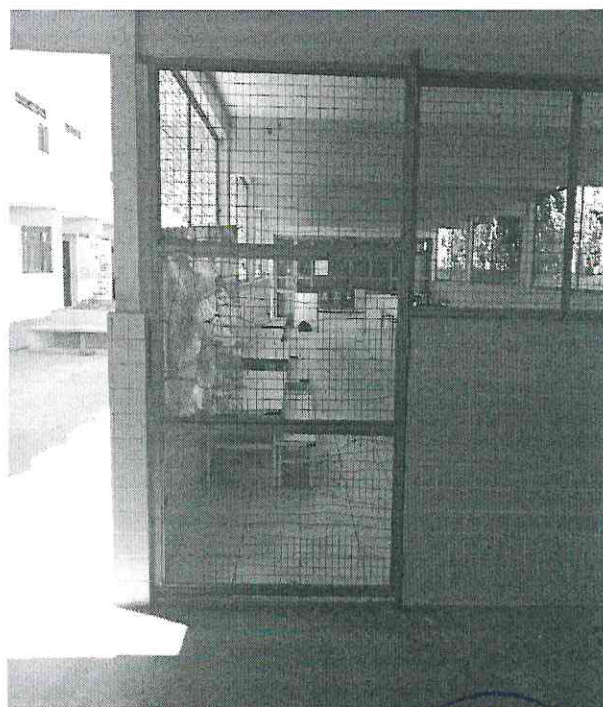
12. Refeitório – substituição de alambrado.
