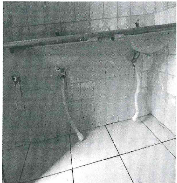
2. Banheiro dos alunos - substituição das bancadas.
