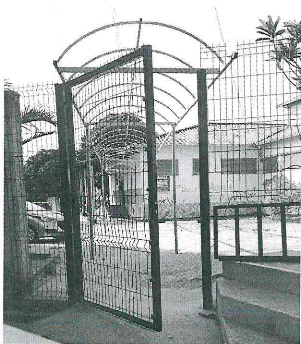
11. Entrada - substituição dos alambrados.
