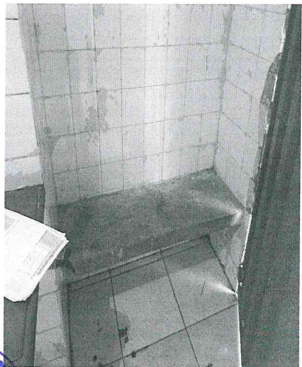
4. Banheiro dos alunos - reforma do banco.
