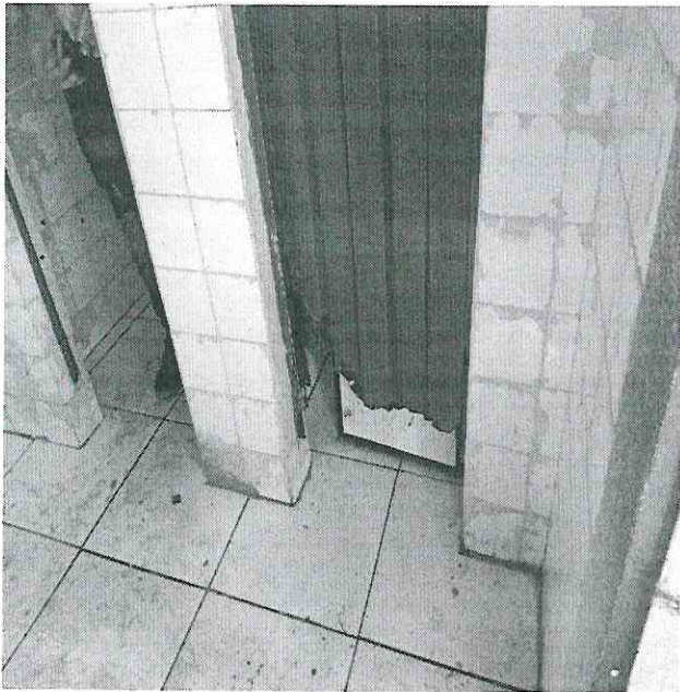
1. Banheiro dos alunos - substituição das portas.
