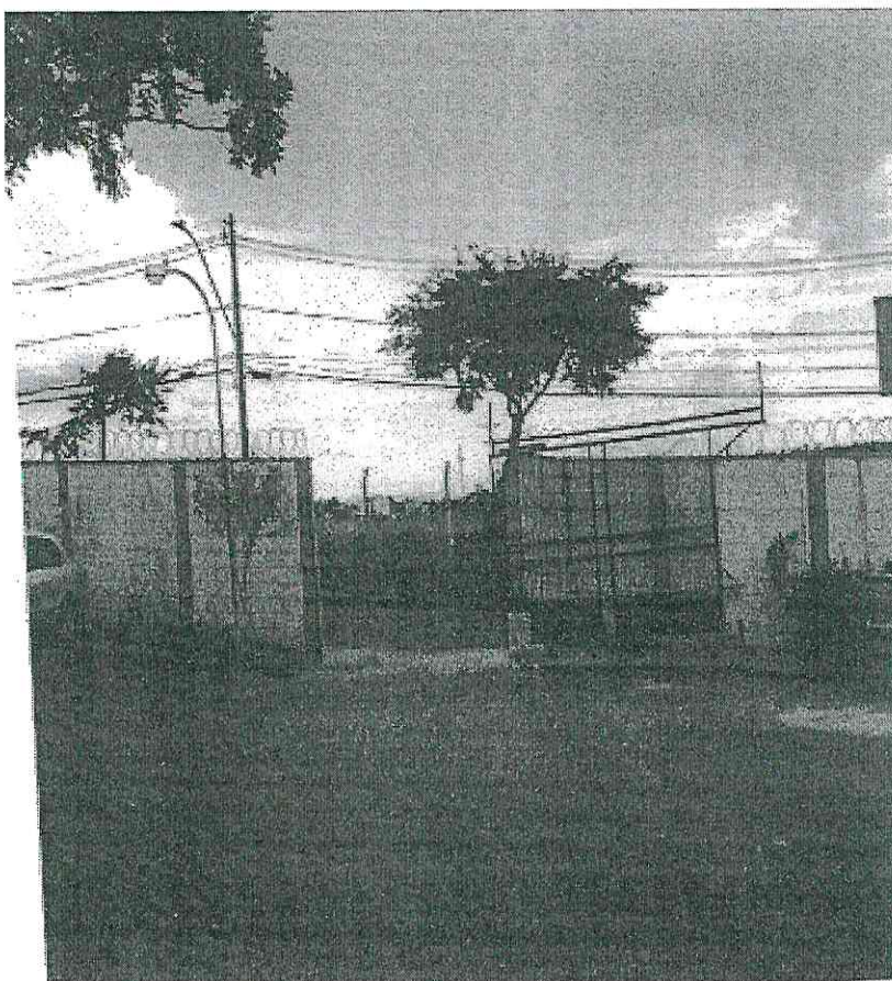
Figura 1: Estacionamento: local de construção de guarita.
