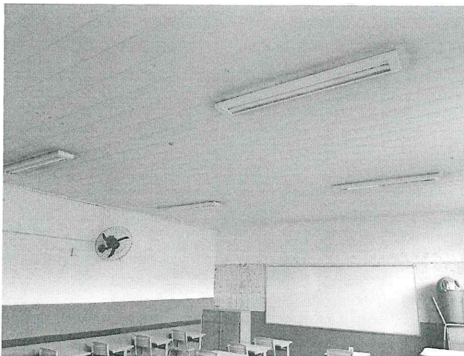
Figura 6: Readaptação de sala para construção de banheiro fem/masc - PNE e Educação infantil
