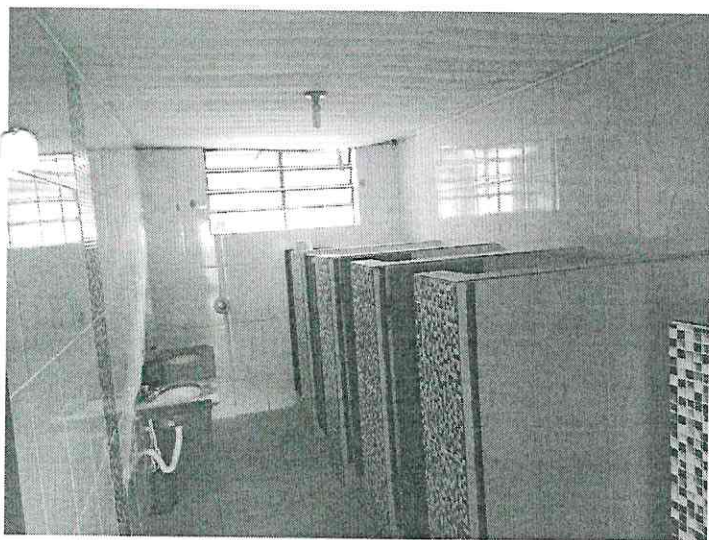
Figura 8: Reforma do banheiro
