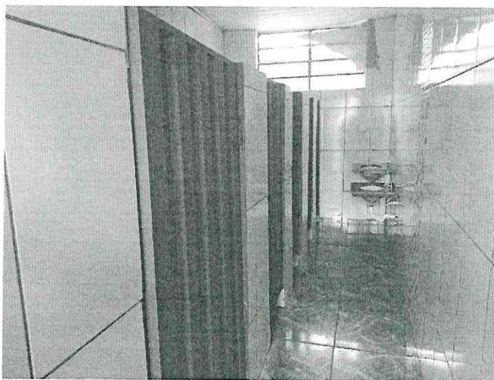
Figura 7: Reforma do banheiro
