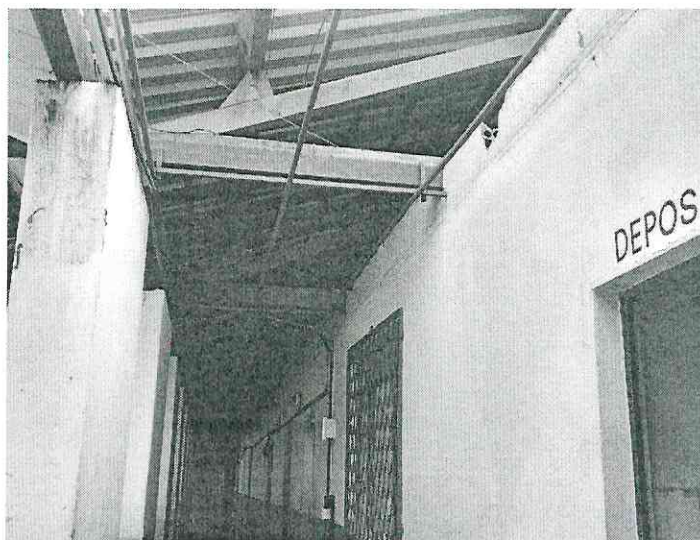
Figura 13: Instalação da rede elétrica
