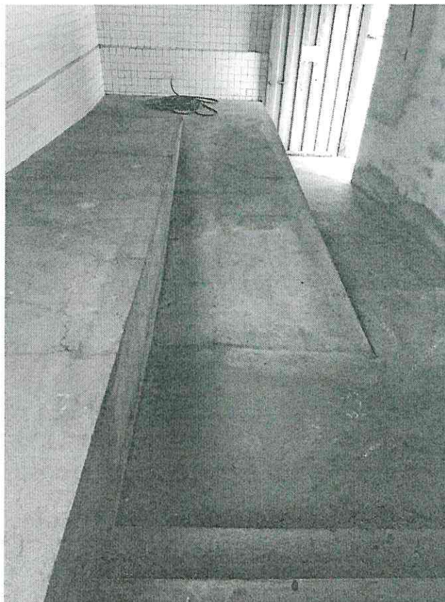
Figura 23: Rampa e escada do acesso pela rua Rio Tibre
