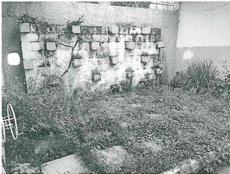
Figura 11: Muro que será reconstruído
