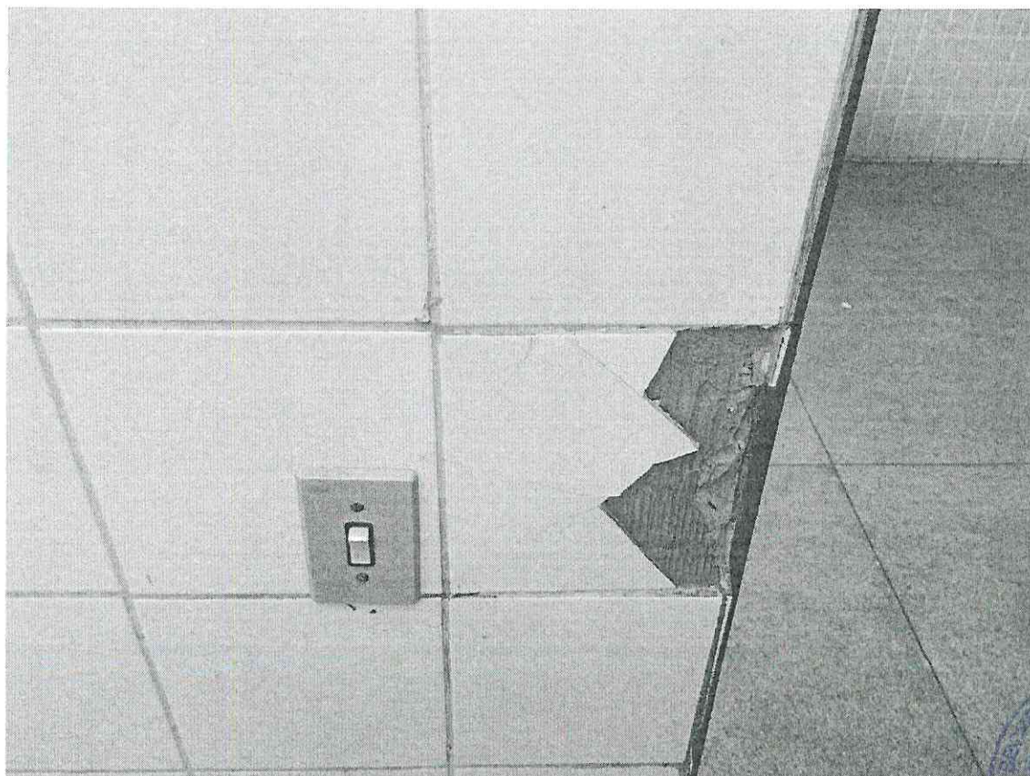
Figura 8: Azulejo da entrada do banheiro.
