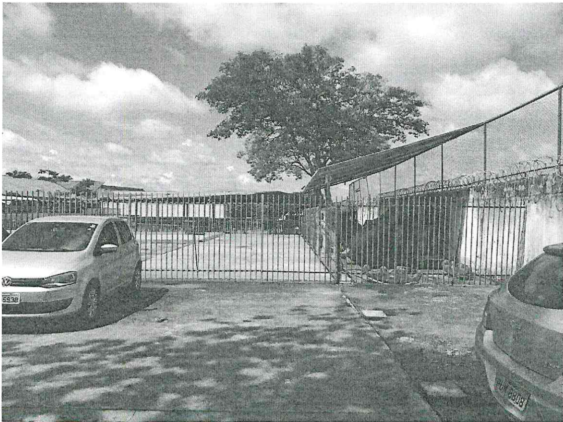
Figura 4: Visão do estacionamento da área de construção das novas salas.
