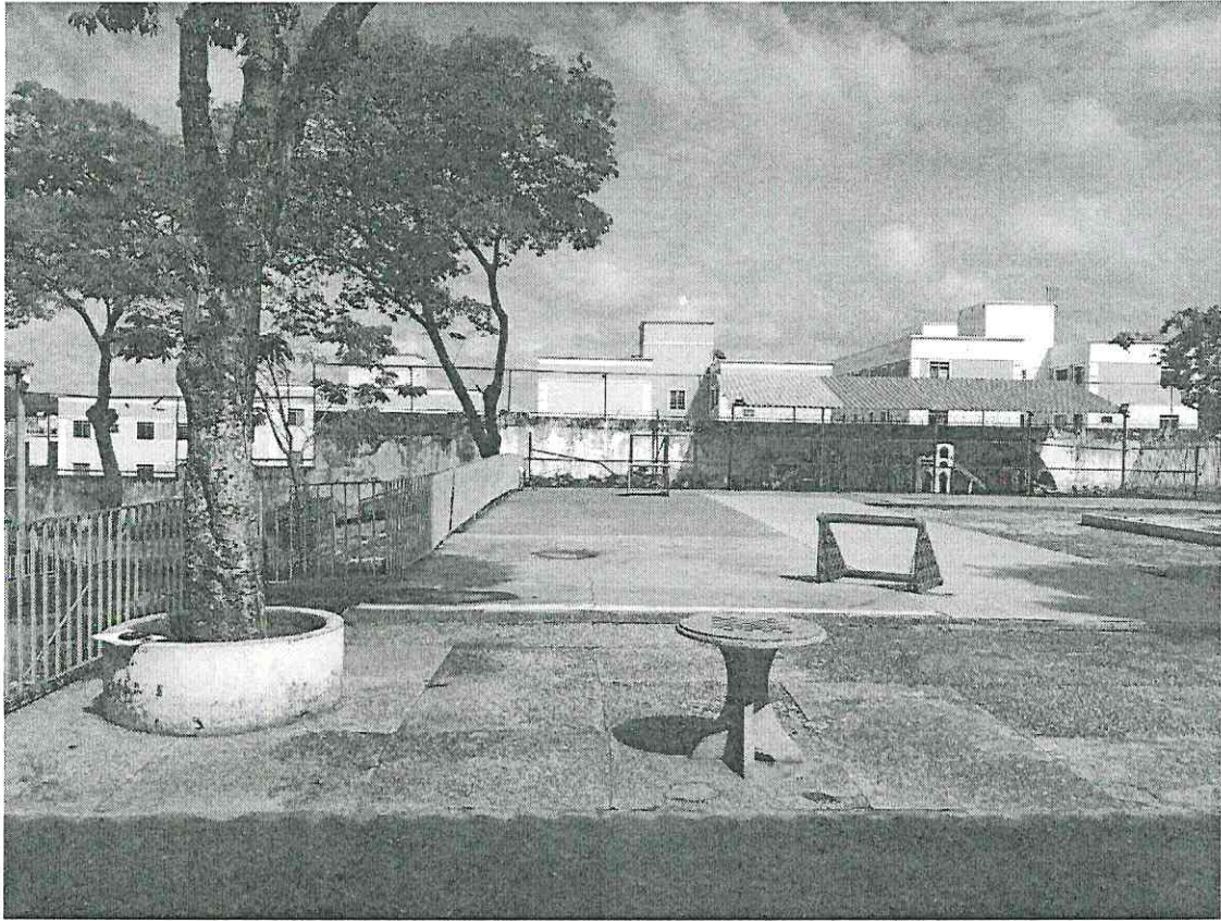
Figura 3: Visão de longe da área a ser construído as novas sala.
