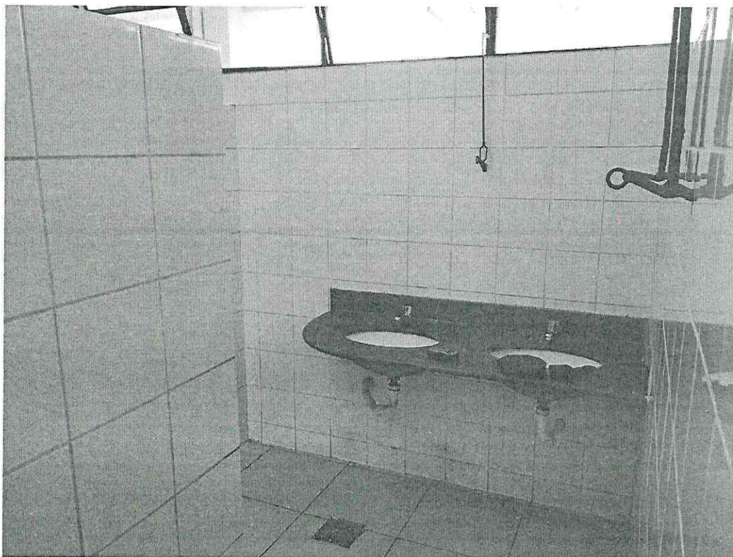
Figura 5: Bancada do banheiro.
