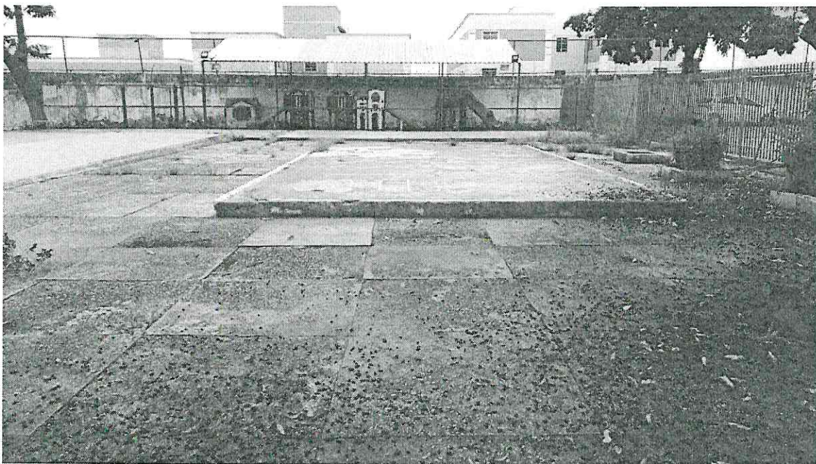
Figura 12: Instalação de cobertura no parquinho
