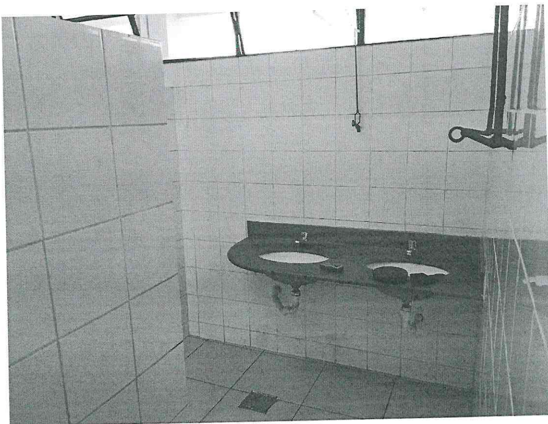
Figura 5: Bancada do banheiro.
