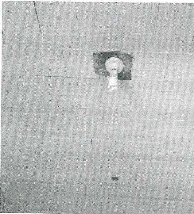
3. Teto - interior da sala 1.
