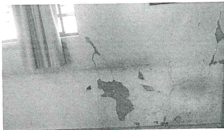
Figura 6: Paredes descascando
