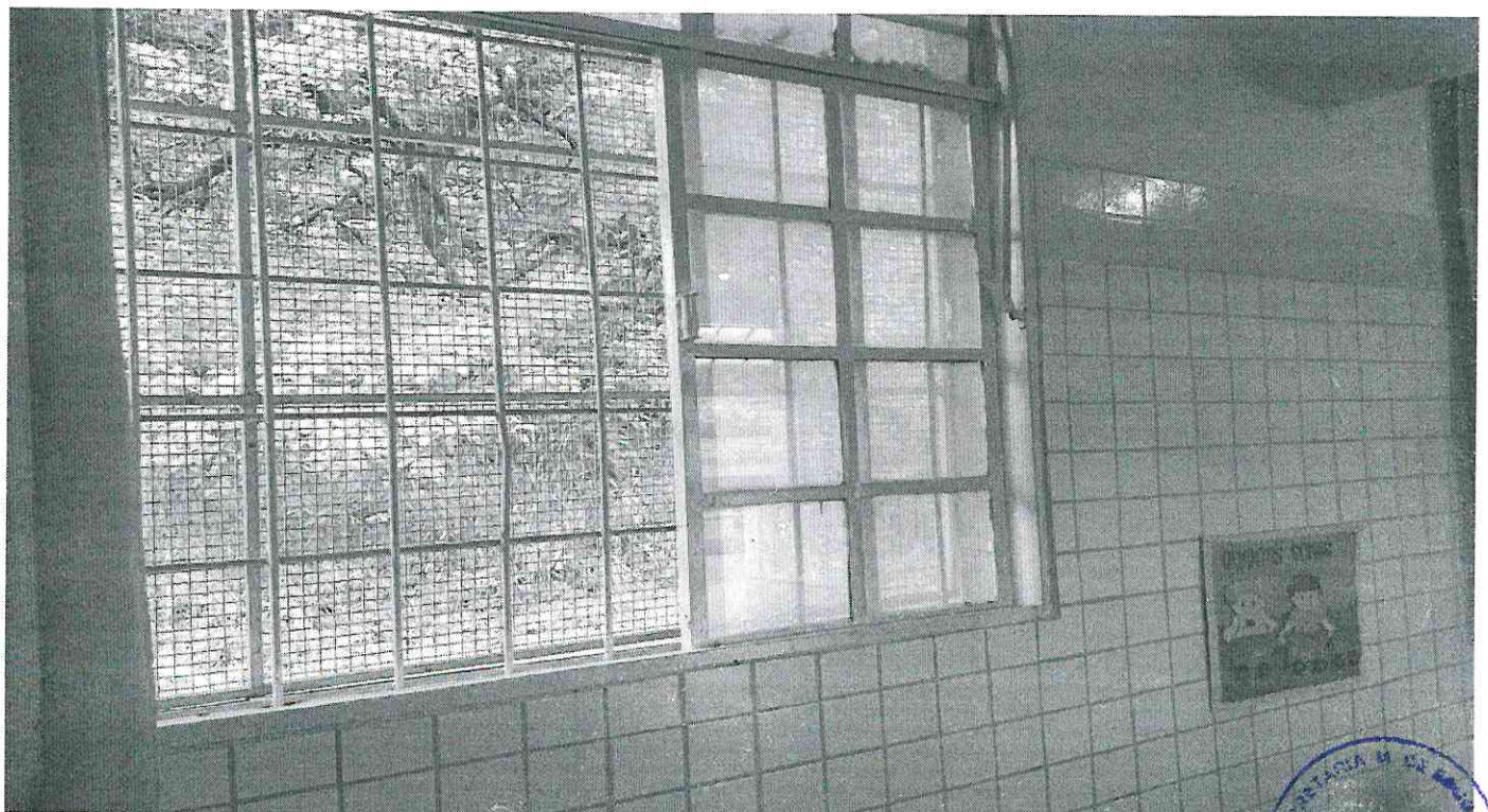
8. Instalar telas nas janelas.
