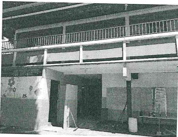
Pintura das partes externas e arquibancada da escola.
