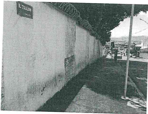
Pintura do muro e da arquibancada.
