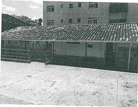
Pintura das paredes externas
