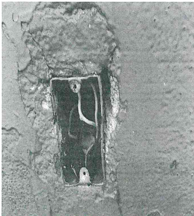
4. Manutenção da rede elétrica.
