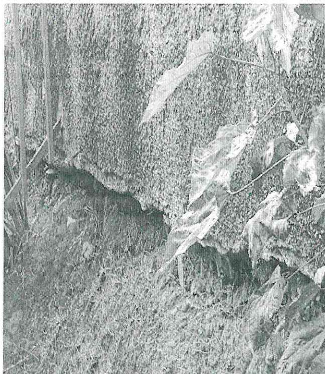
10. Reforma do muro – reestruturar a base.
