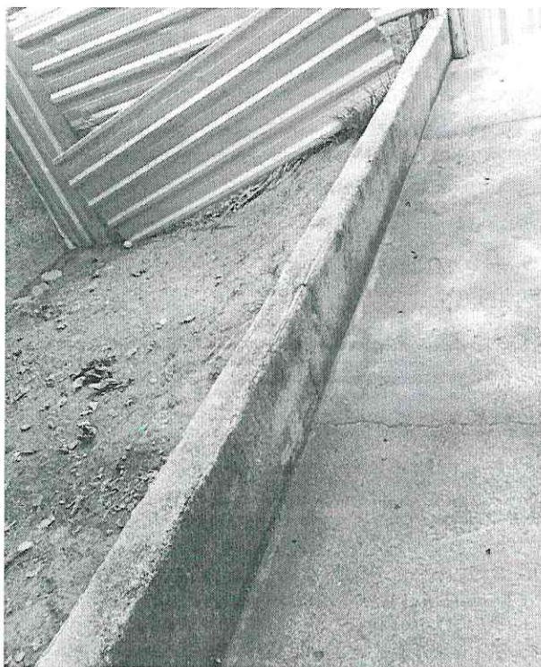
9. Reforma do muro com retirada da mureta.
