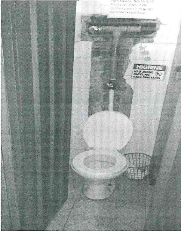
5. Paredes do banheiro dos alunos.
