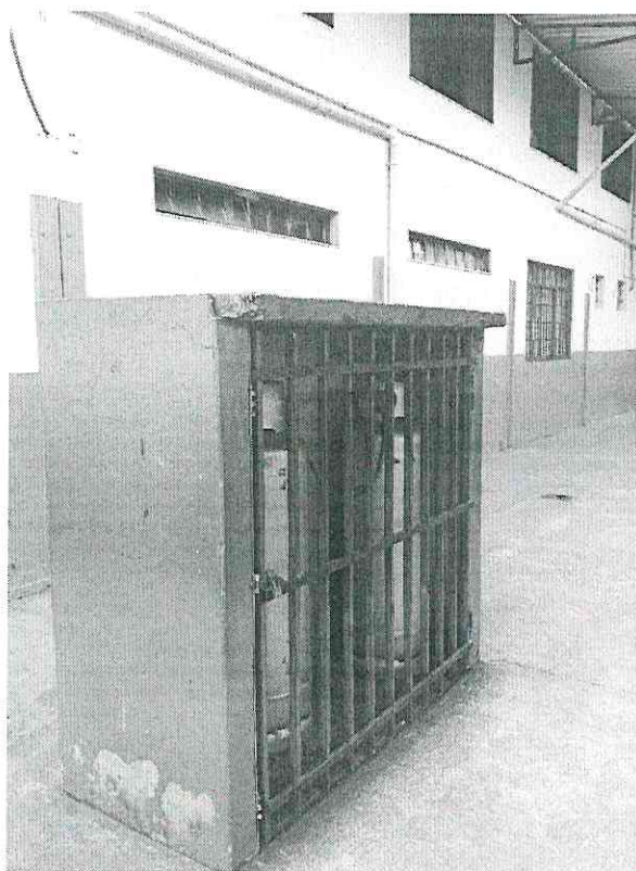
11. Depósito de gás no pátio principal - retirar.
