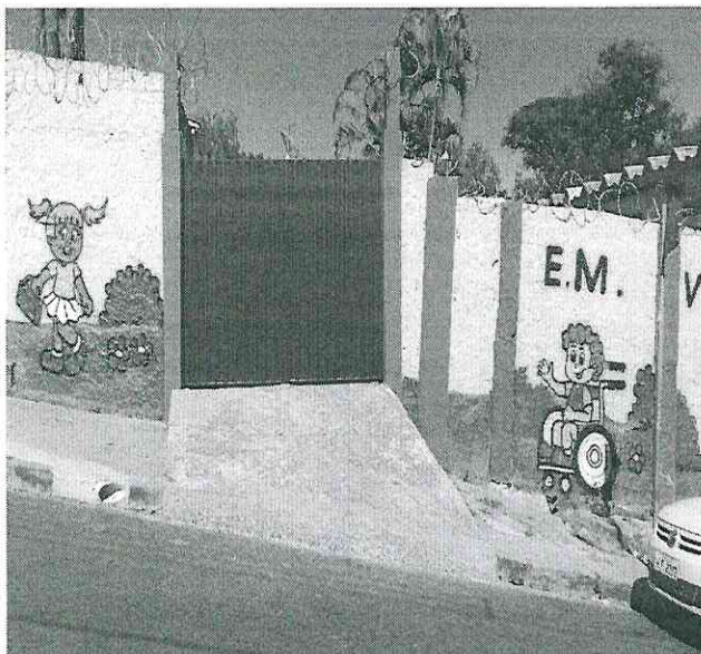
4. Vista do lado de fora da rampa – entrada principal.
