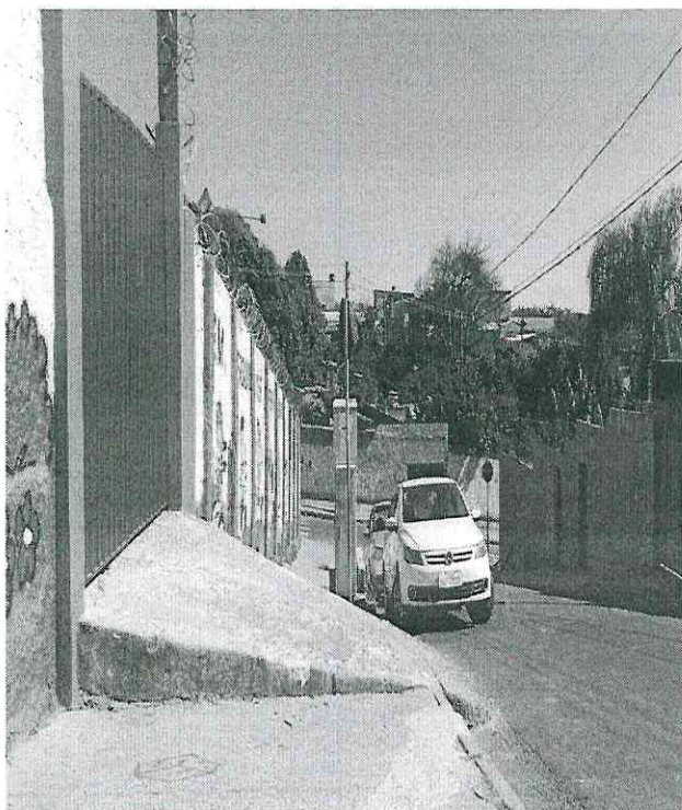
6. Vista lateral da rampa – entrada principal.
