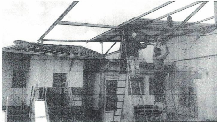
REFORMA DE SALAS
