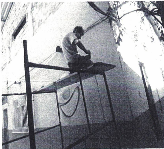
REPARO NA ESTALAÇÃO ELETRICA
