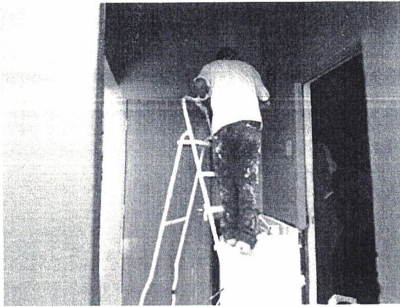
REFORMA DO BANHEIRO
